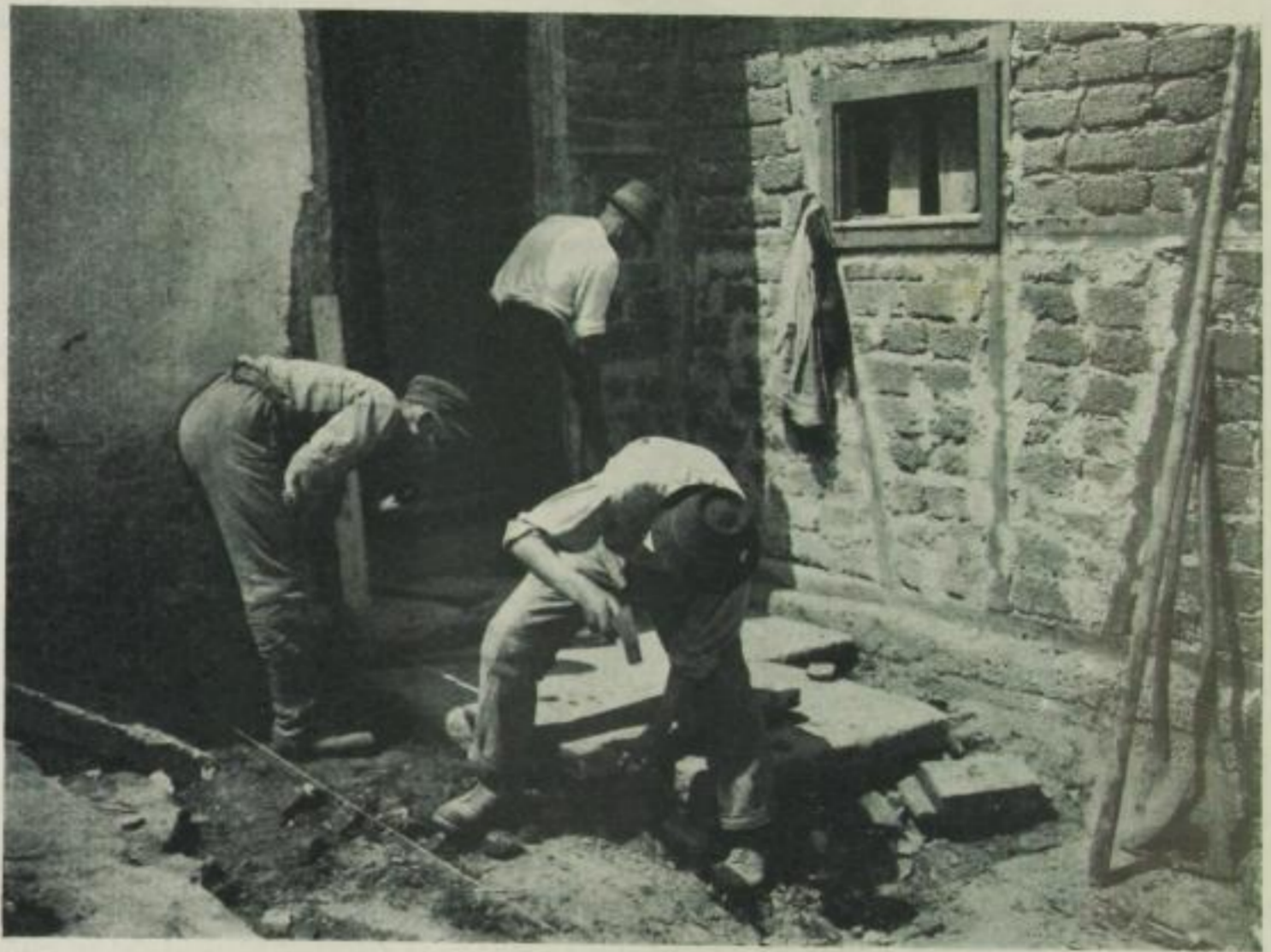
Bei der Bauarbeit
