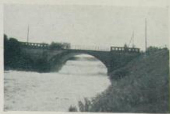
Dahmebrücke mit Wehr
