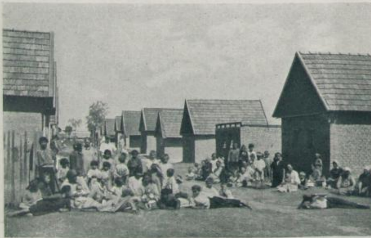
Neue Siedlung in Senta
