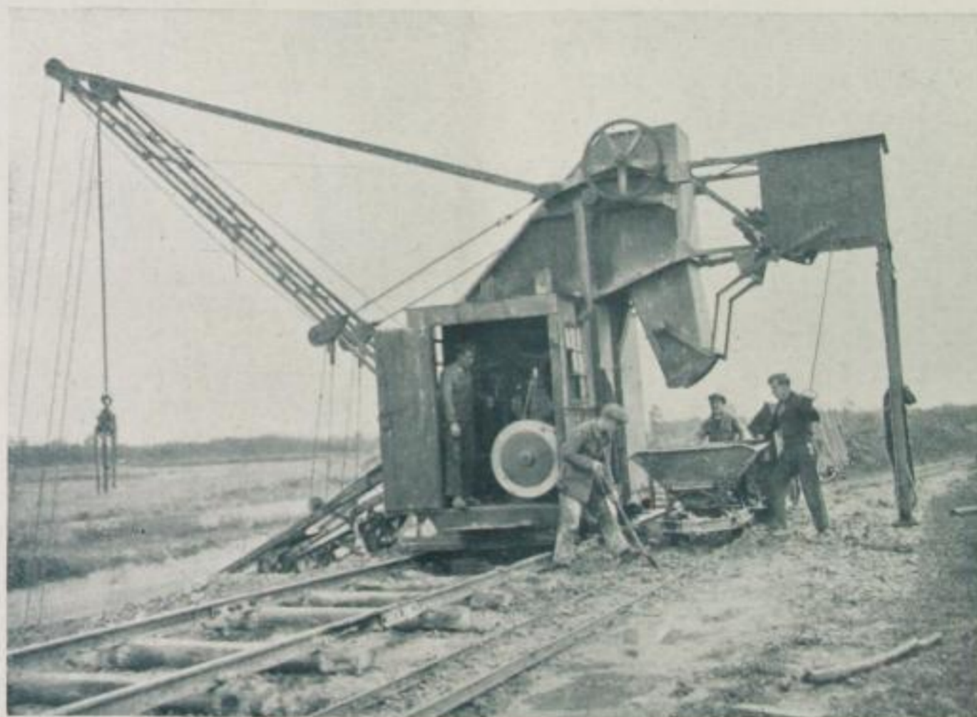
Arbeiter am Ziegeleibagger
