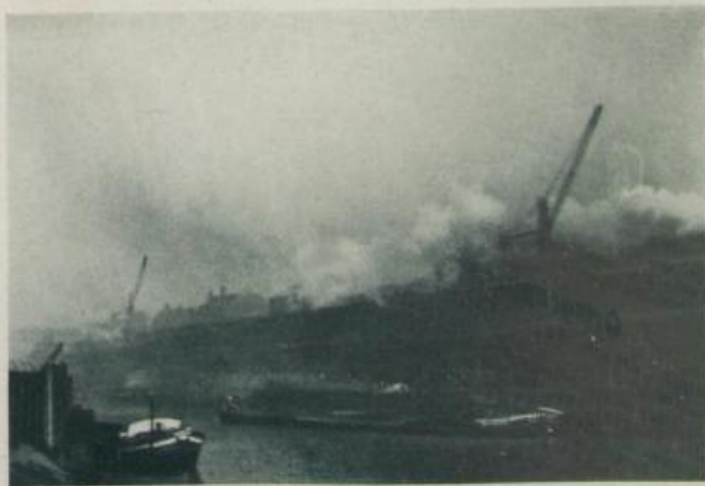
An der Jannowitzbrücke
