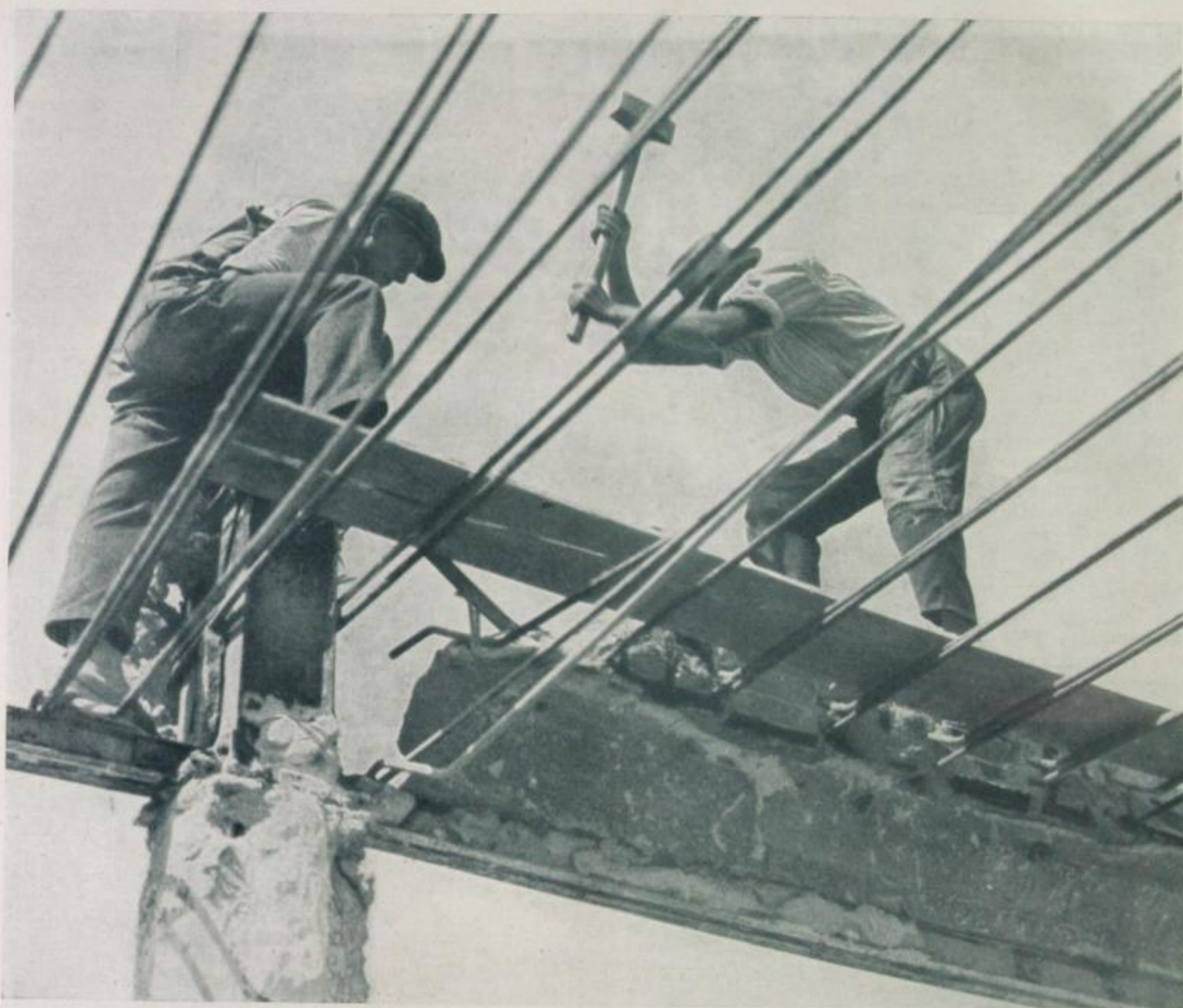
Auf dem Betonträger
