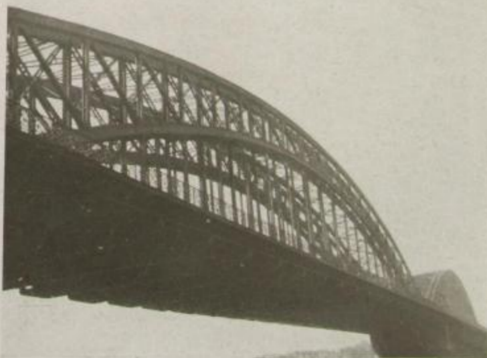
Rheinbrücke Beispiel zum Aufsatz: „Einiges über neues Schön“
